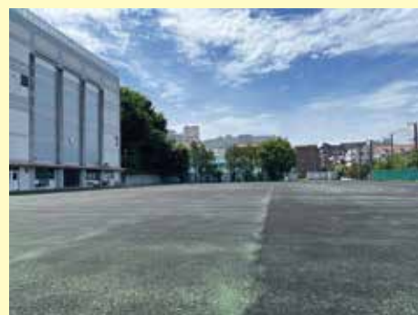
【Before: 改修前の下校庭】
